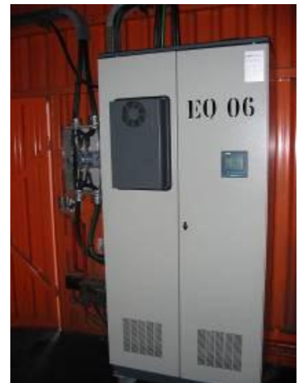
FIGURA 2 Compensador estático de energia reativa
