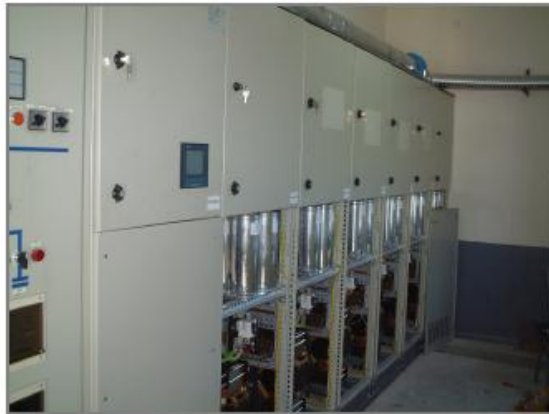
Figura 1 – Compensador de energia reativa 3000 kvar – 690V
