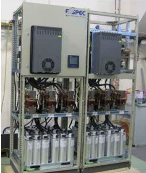
FIGURA 3 – FILTRO PASSIVO COM MANOBRA ESTÁTICA DE 6 ESTÁGIOS
